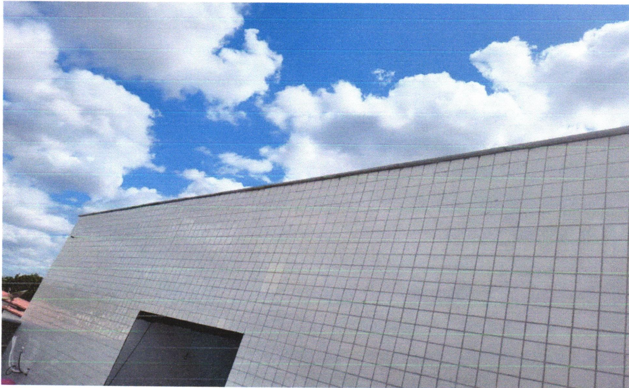
FOTO 08 - CHAPIM DE CONCRETO PRÉ-MOLDADO
