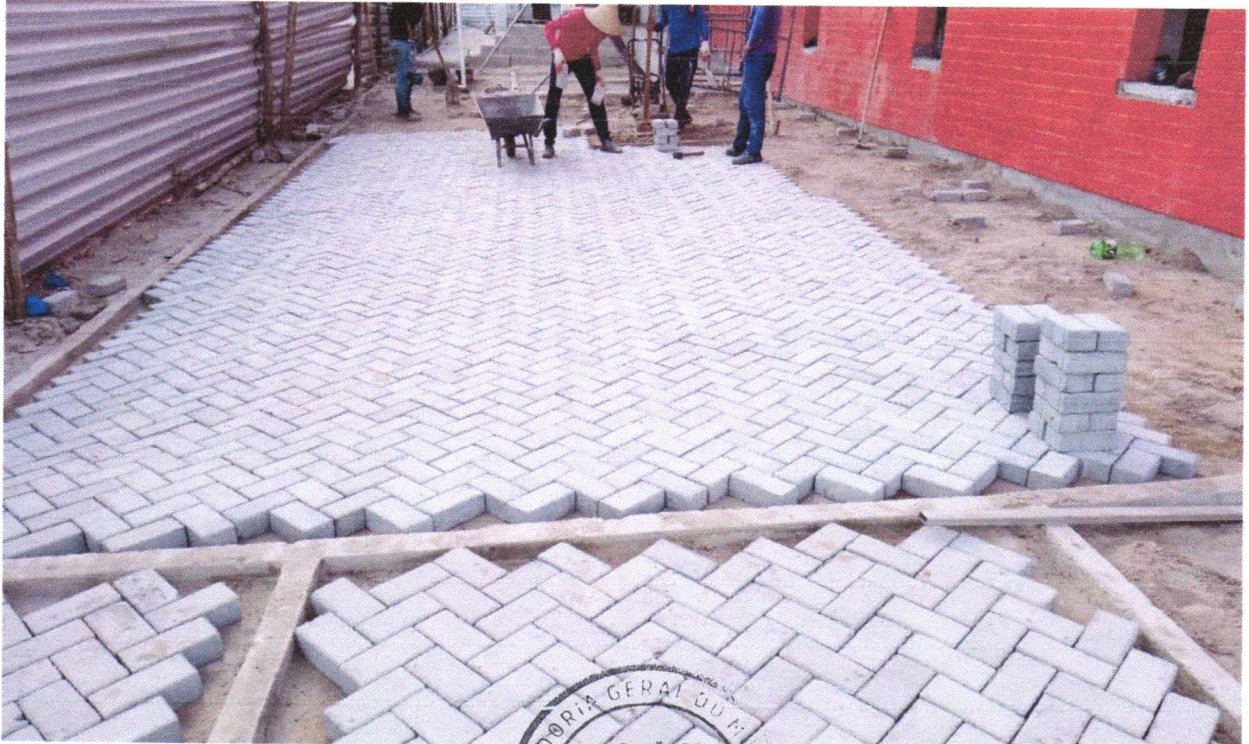
FOTO 20 - EXECUÇÃO DE PÁTIO/ESTACIONAMENTO EM PISO INTERTRAVADO, COM BLOCO RETANGULAR DE 20 X 10 CM, ESPESSURA 10 CM. AF_12/2015
