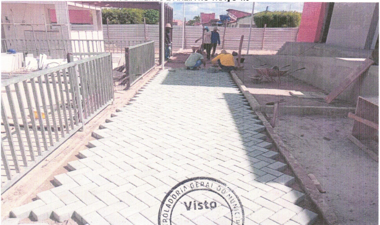
FOTO 26 - GUIA, DIVISÓRIA, EM MEIO-FIO PRÉ MOLDADO DE CONCRETO SIMPLES (0,12 X 0,30 X 1,00 M), REJUNTADO COM ARGAMASSA DE CIMENTO E AREIA NO TRAÇO 1:3
