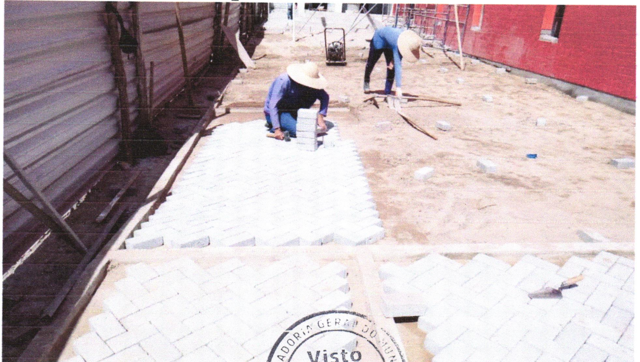
FOTO 20 - EXECUÇÃO DE PÁTIO/ESTACIONAMENTO EM PISO INTERTRAVADO, COM BLOCO RETANGULAR DE 20 X 10 CM, ESPESSURA 10 CM. AF_12/2015
