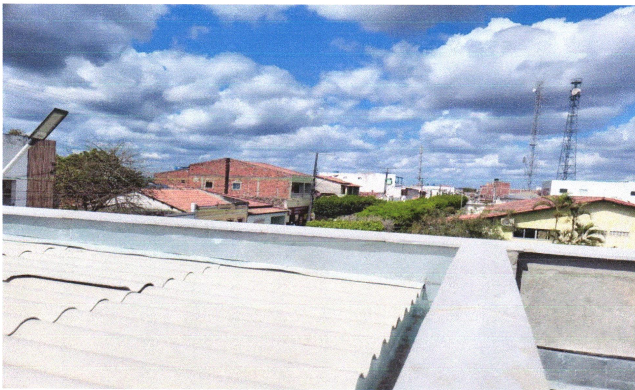
FOTO 06 - CHAPIM DE CONCRETO PRÉ-MOLDADO
