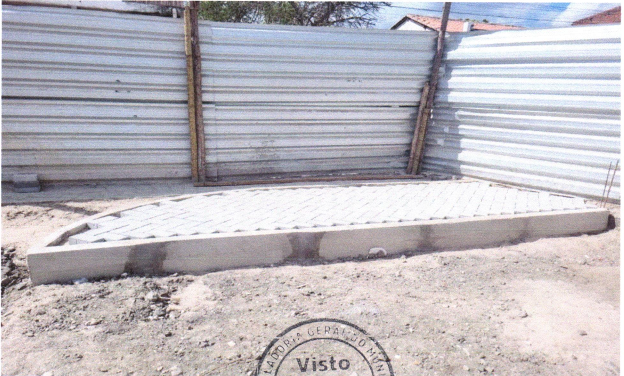
FOTO 24 - EXECUÇÃO DE PASSEIO EM PISO INTERTRAVADO, COM BLOCO RETANGULAR COR NATURAL DE 20 X 10 CM, ESPESSURA 6 CM. AF_12/2015
