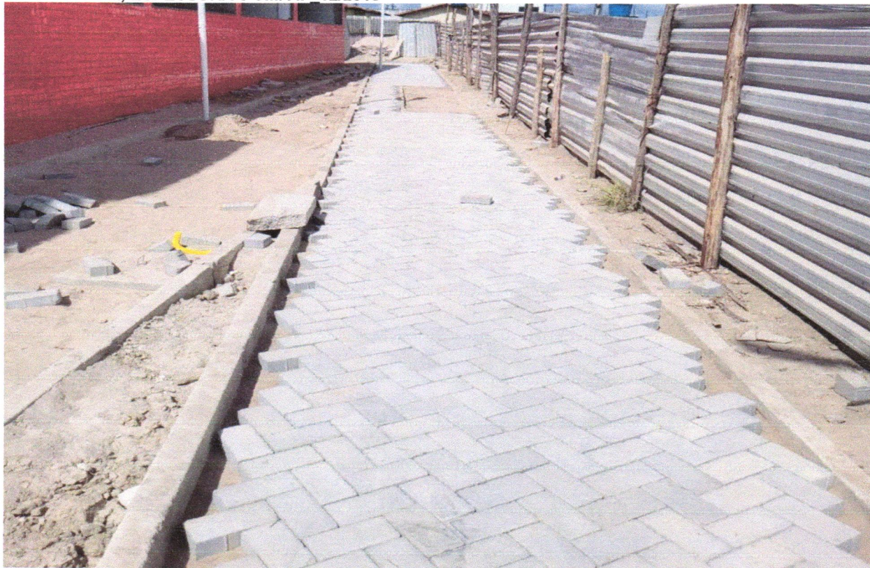
FOTO 24 - EXECUÇÃO DE PASSEIO EM PISO INTERTRAVADO, COM BLOCO RETANGULAR COR NATURAL DE 20 X 10 CM, ESPESSURA 6 CM. AF_12/2015
