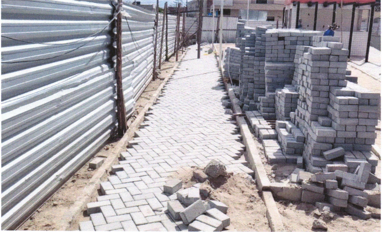
FOTO 24 - EXECUÇÃO DE PASSEIO EM PISO INTERTRAVADO, COM BLOCO RETANGULAR COR NATURAL DE 20 X 10 CM, ESPESSURA 6 CM. AF_12/2015
